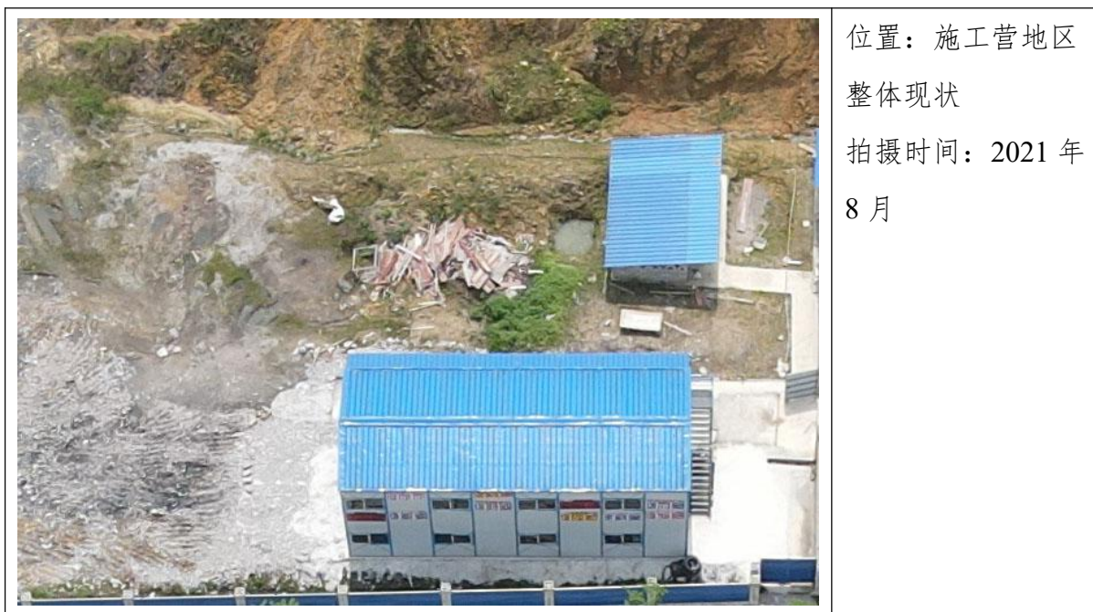
图 3.1-2 施工营地区现状
