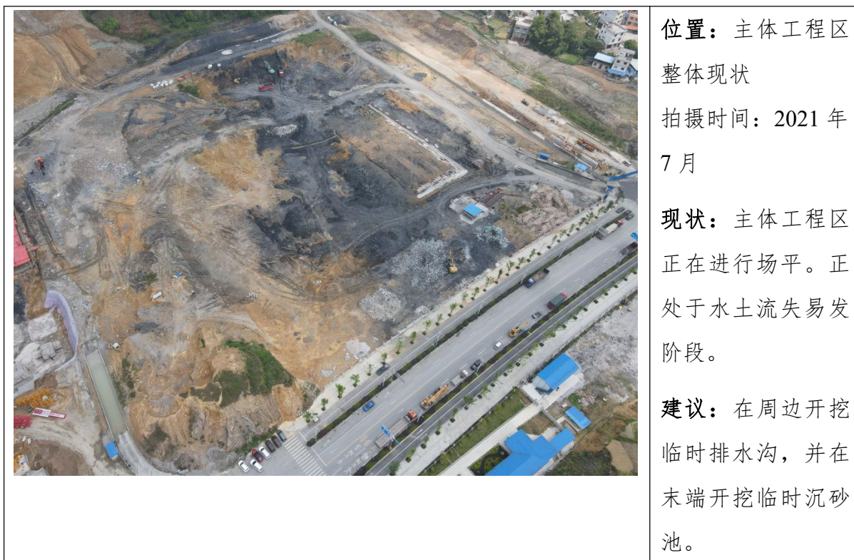
图 3.1-1 主体工程区施工现状
