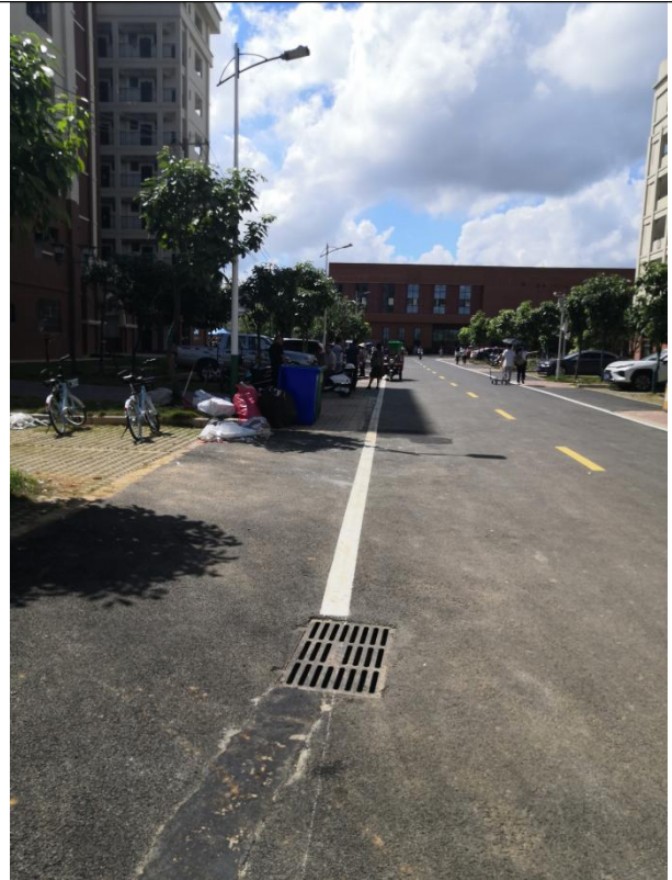
本项目西面照片
