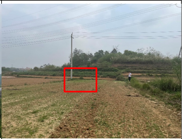
91#塔基施工恢复现状
