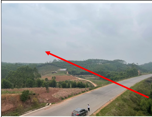
线路跨域省道现状
