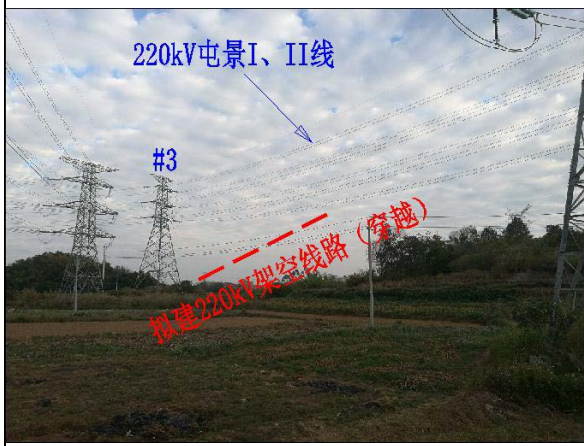
钻越 220kV 屯景 I、II 线现状
