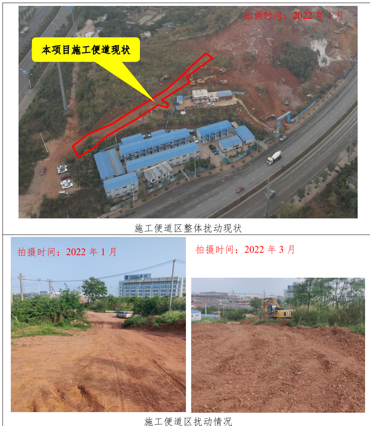
图 3.1-4 施工便道区现场情况
