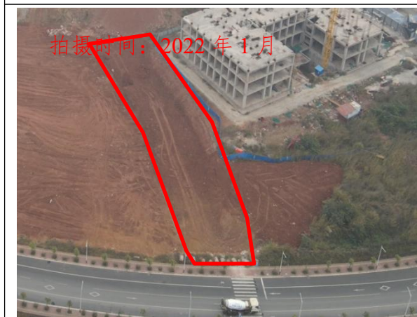
K0+020号桩起点现状
