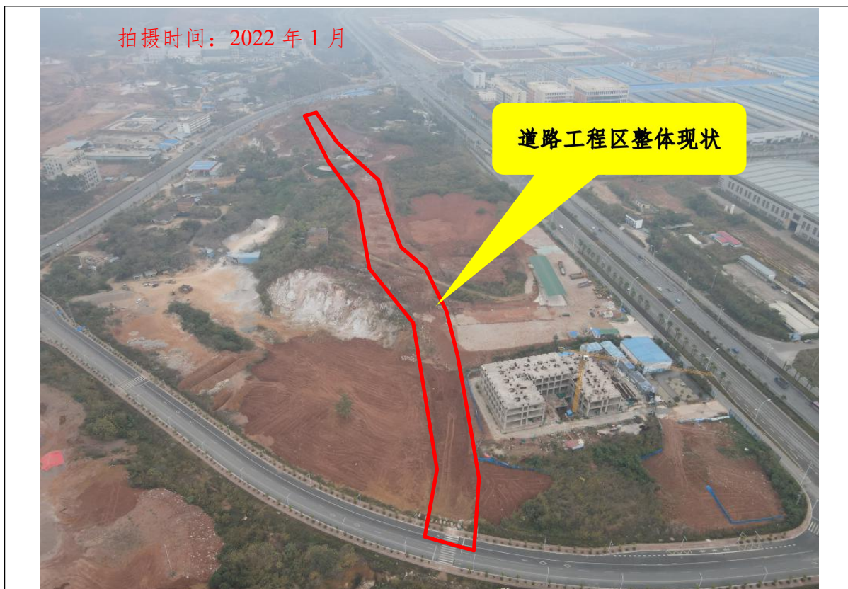
道路工程区整体现状
