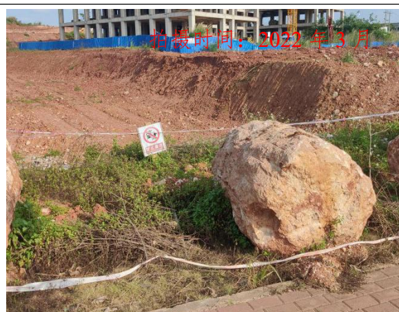
K0+020号桩起点现状
