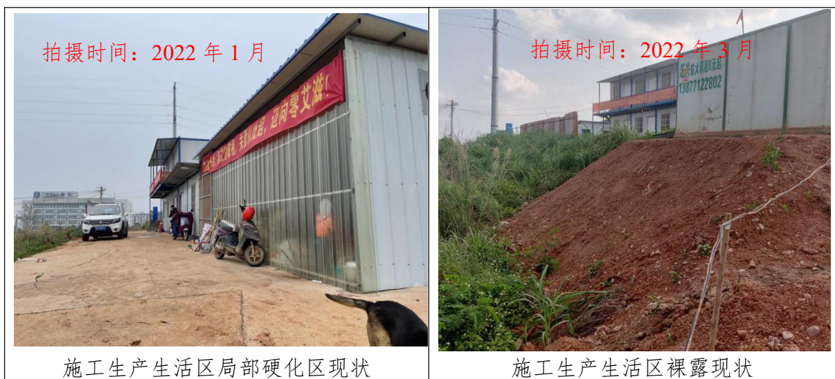
图 3.1-2 施工生产生活区现场情况
