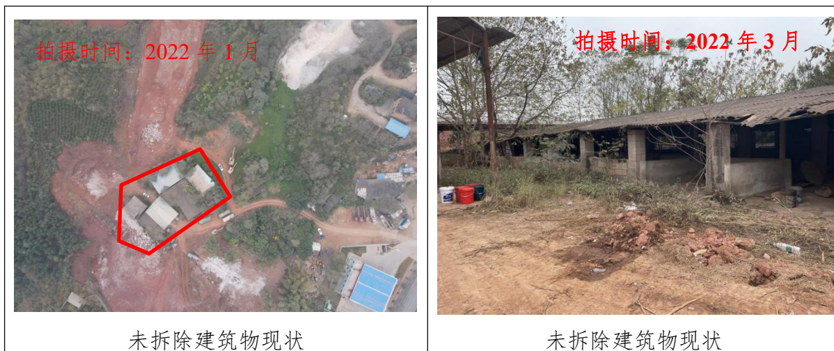
图 3.1-1 道路工程区现场情况
