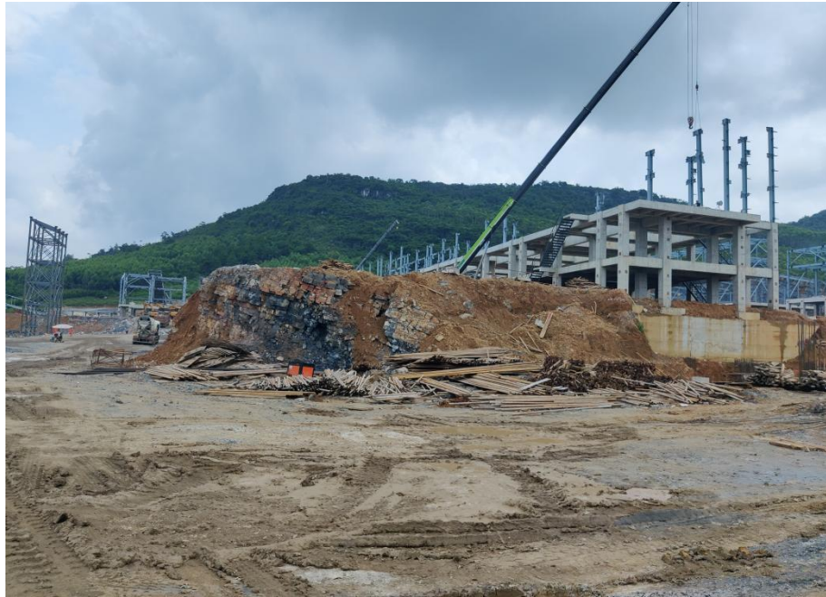
位置：主体工程区 二级筛分车间西 侧，裸露区域 拍摄时间：2022 年6月
