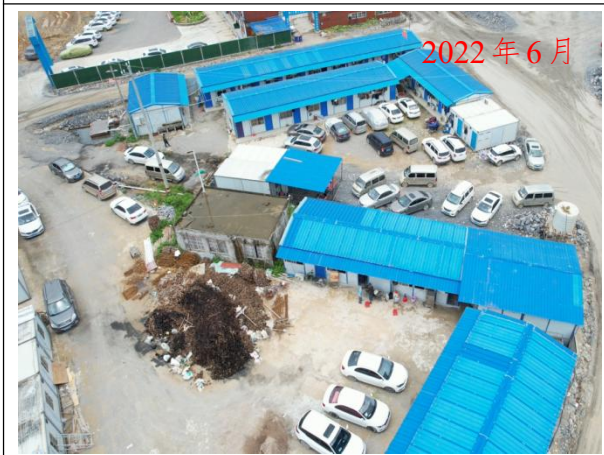
施工生产生活区现状
