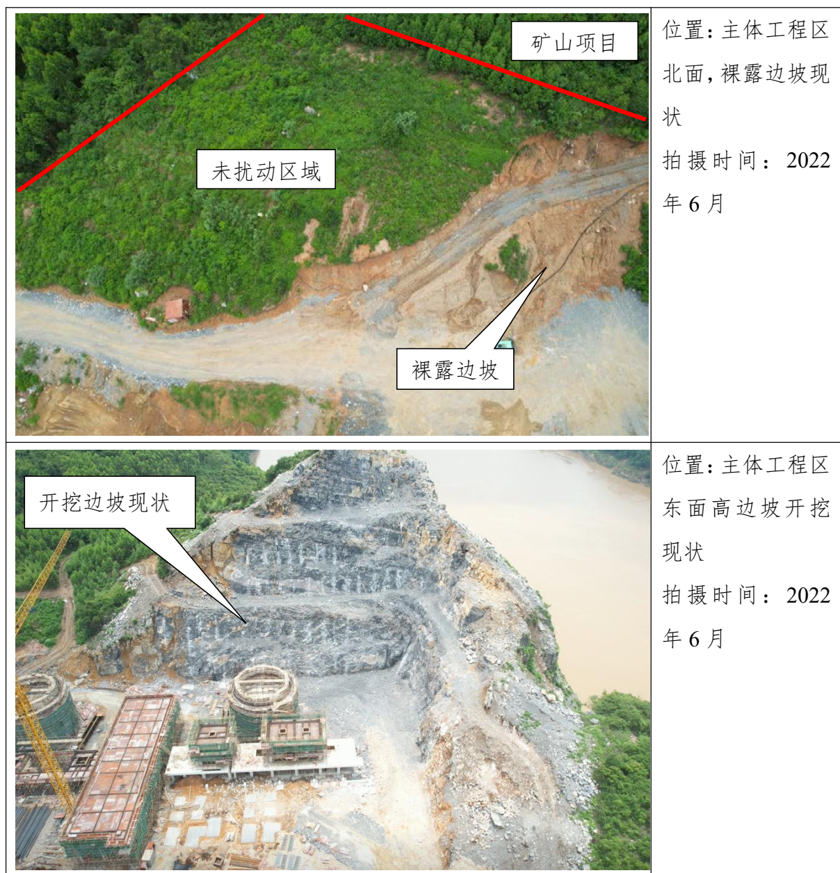
图 3.1-2 主体工程区场地现状照片
