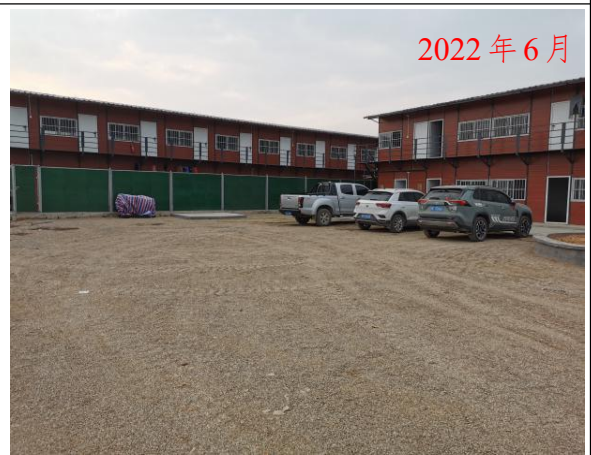
施工生产生活区现状
