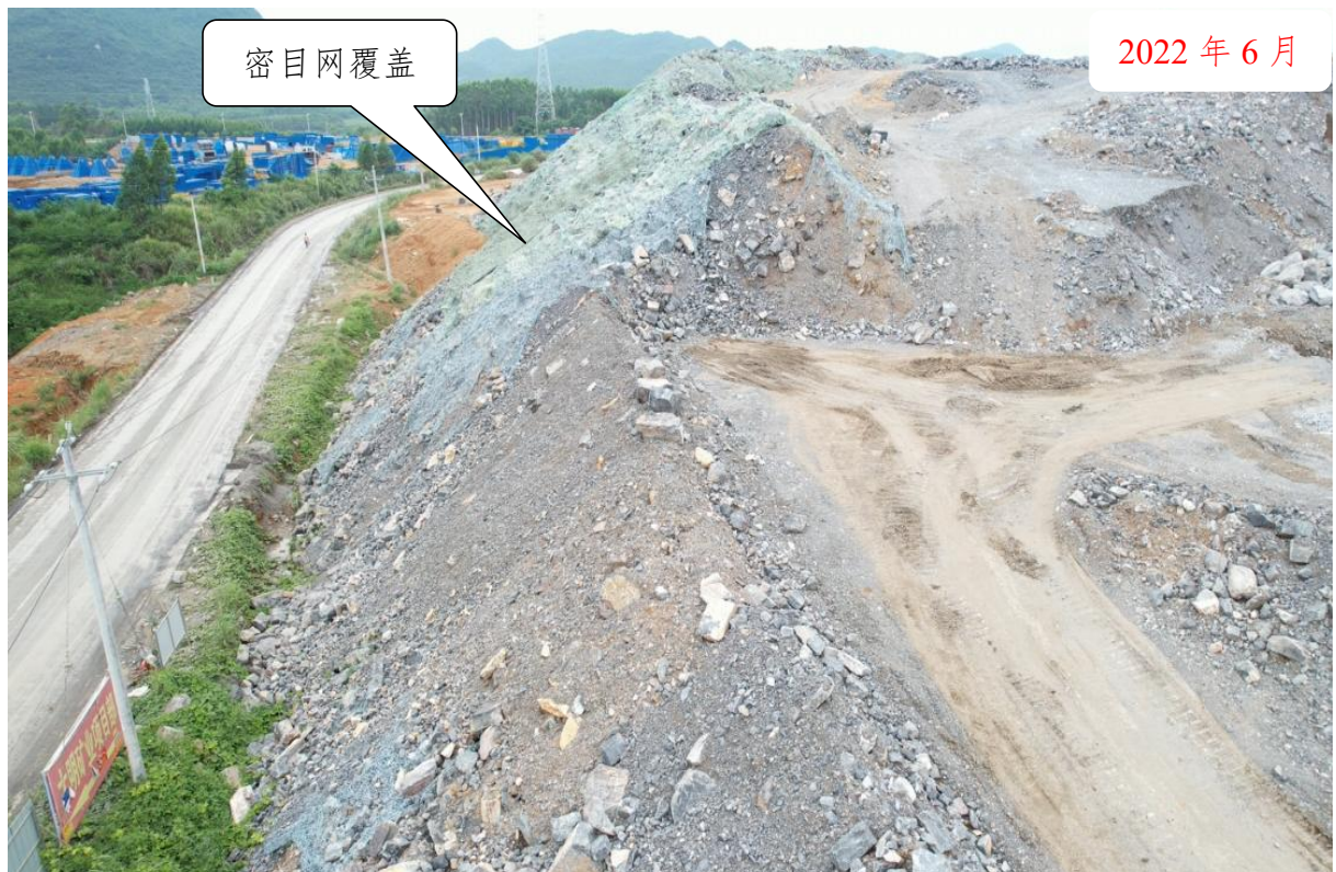
1#临时中转场区局部现状（临时堆放石方为主）
