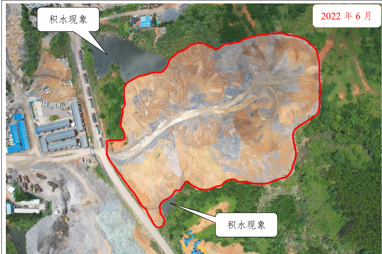
2#临时中转场区整体现状（临时堆放土石方为主）
