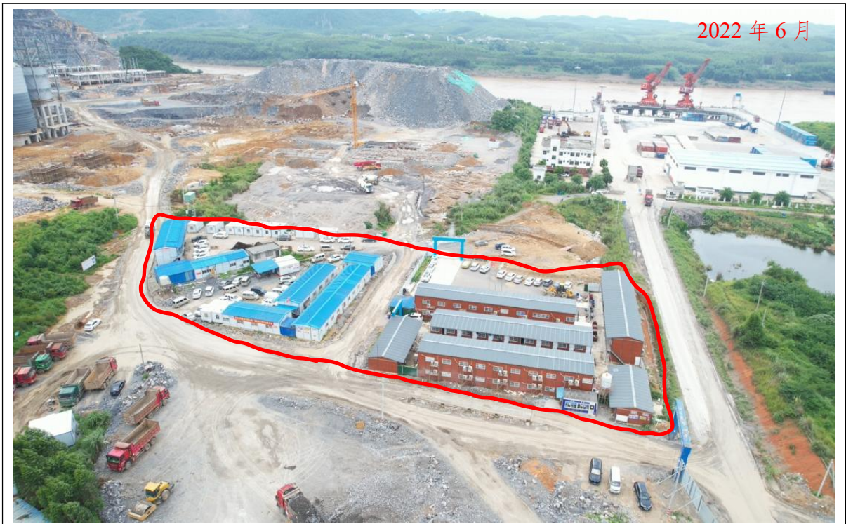
施工生产生活区整体现状
