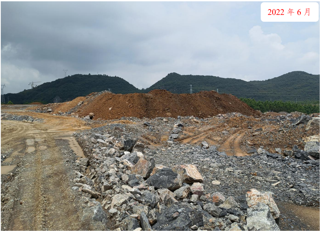
2#临时中转场区局部现状（堆放土石方为主）
