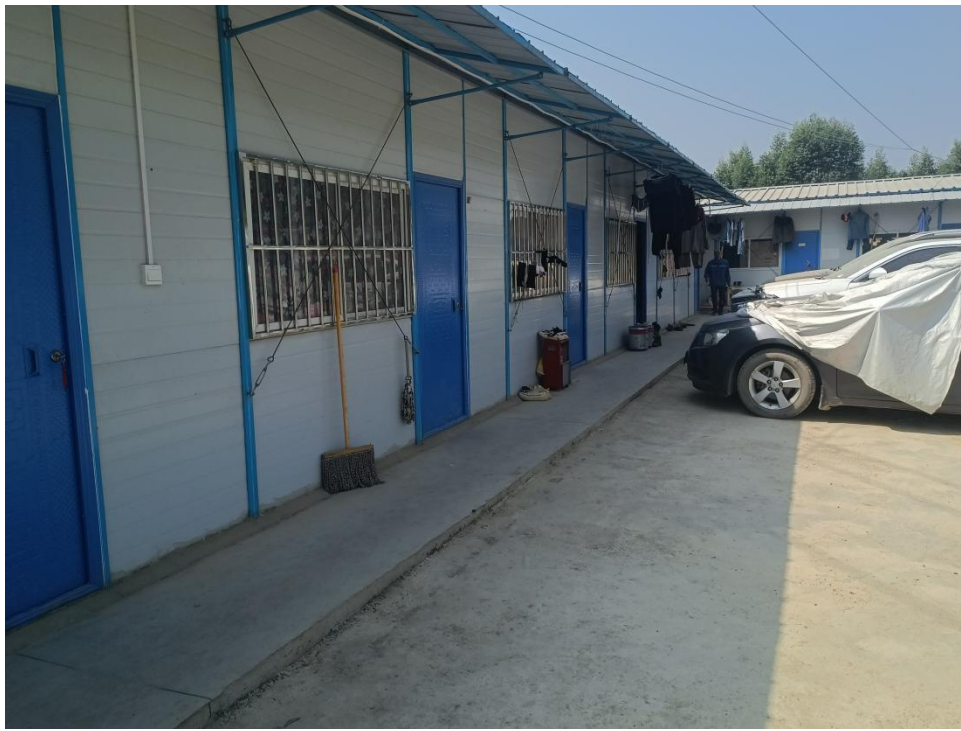
位置：施工生产 生活区现状 拍摄时间：2022 年 9 月
