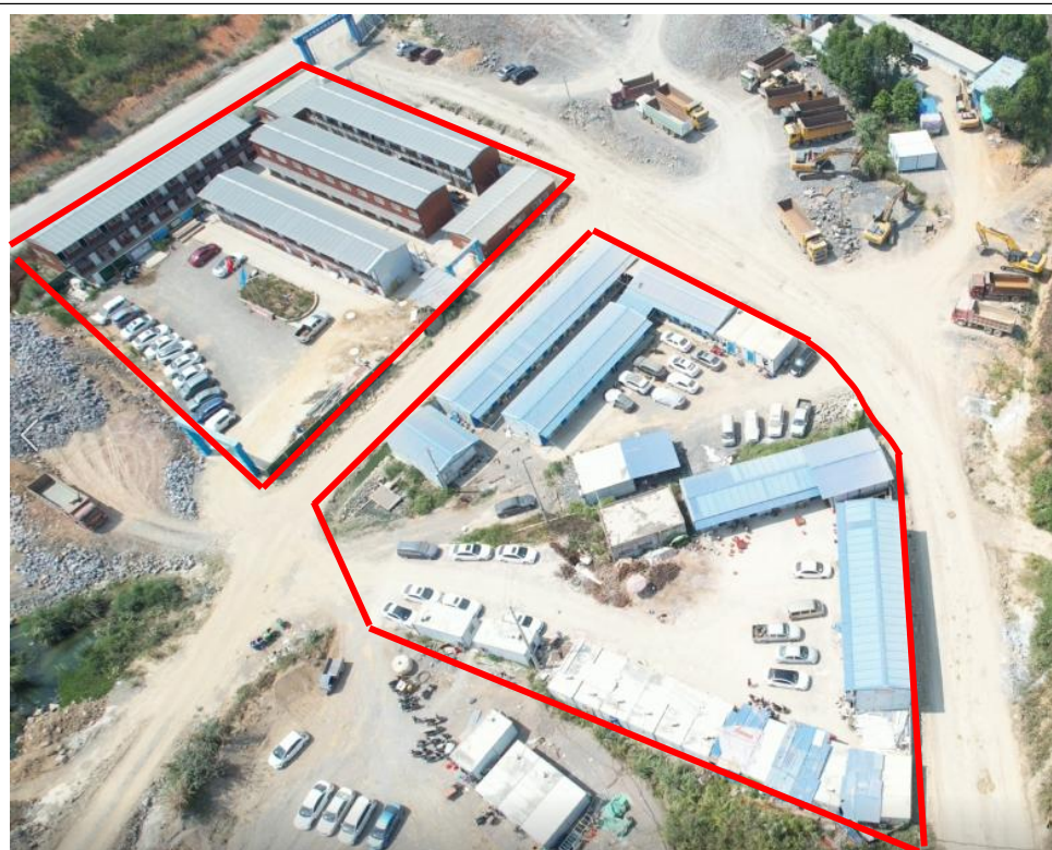
图 3.1-3: 施工生产生活区场地照片
