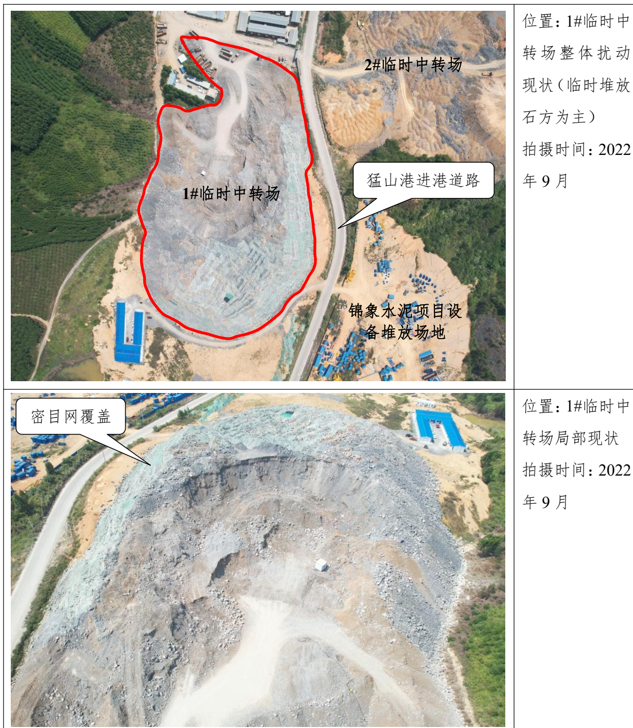
图 3.1-4: 临时中转场场地照片
