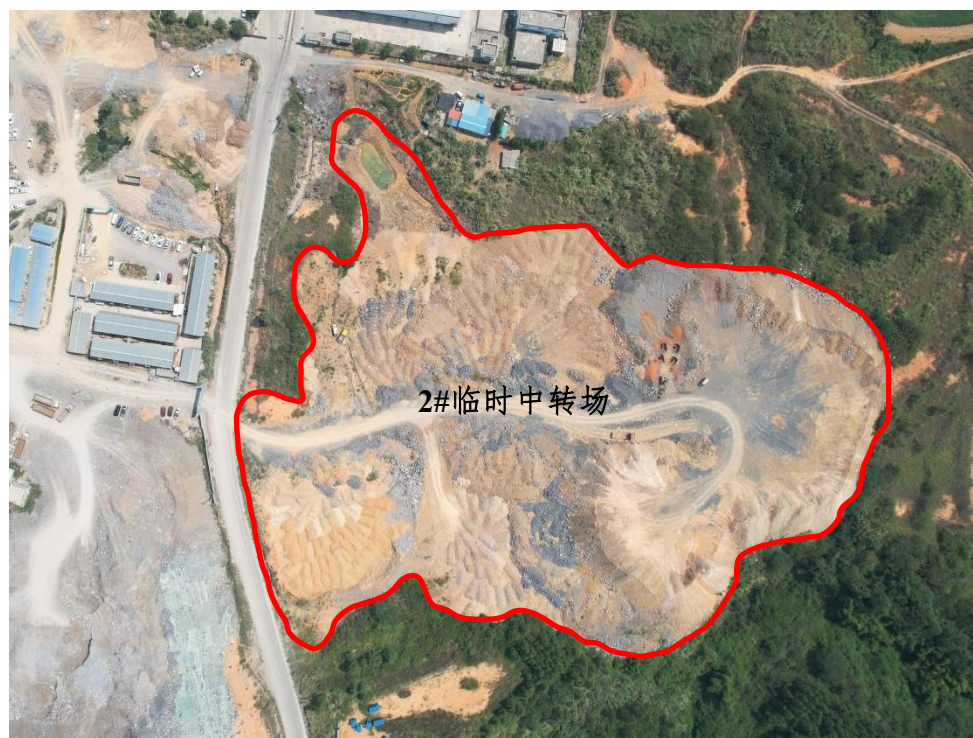
位置：2#临时中 转场整体扰动 现状（临时堆放 以土方为主） 拍摄时间：2022 年 9 月
