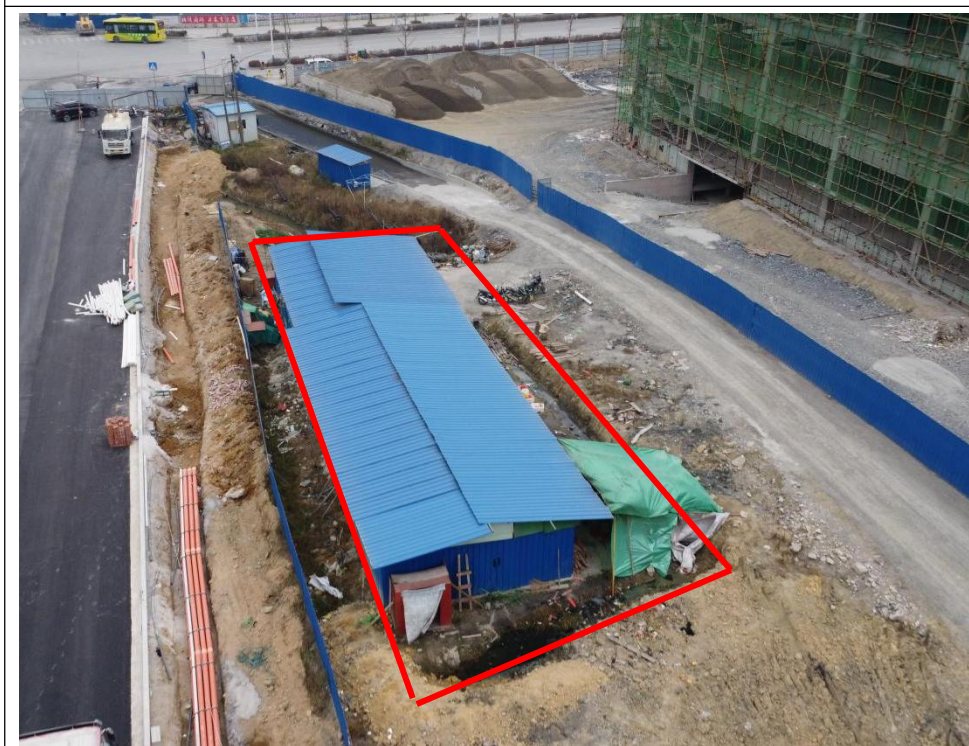
位置：2#施工 营地区整体 扰动现状 拍摄时间： 2022年12月
