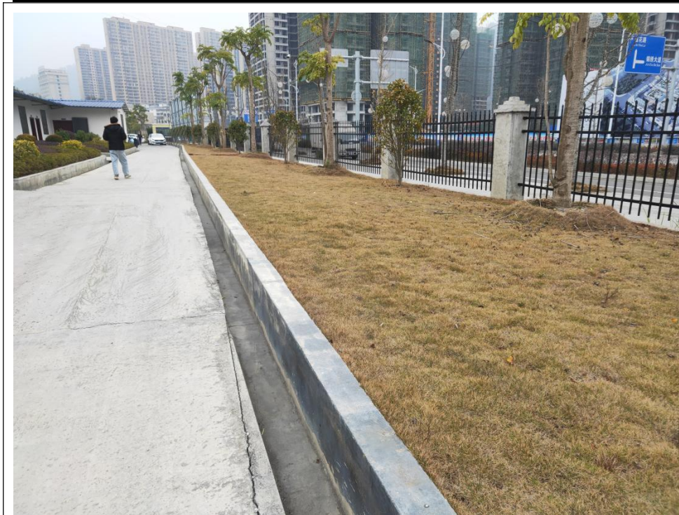
位置：1#施工 营地区绿化 区域及临时 排水沟现状 拍摄时间： 2022年12月
