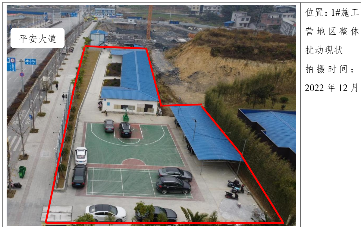
图 3.1-2：施工营地区场地照片：
