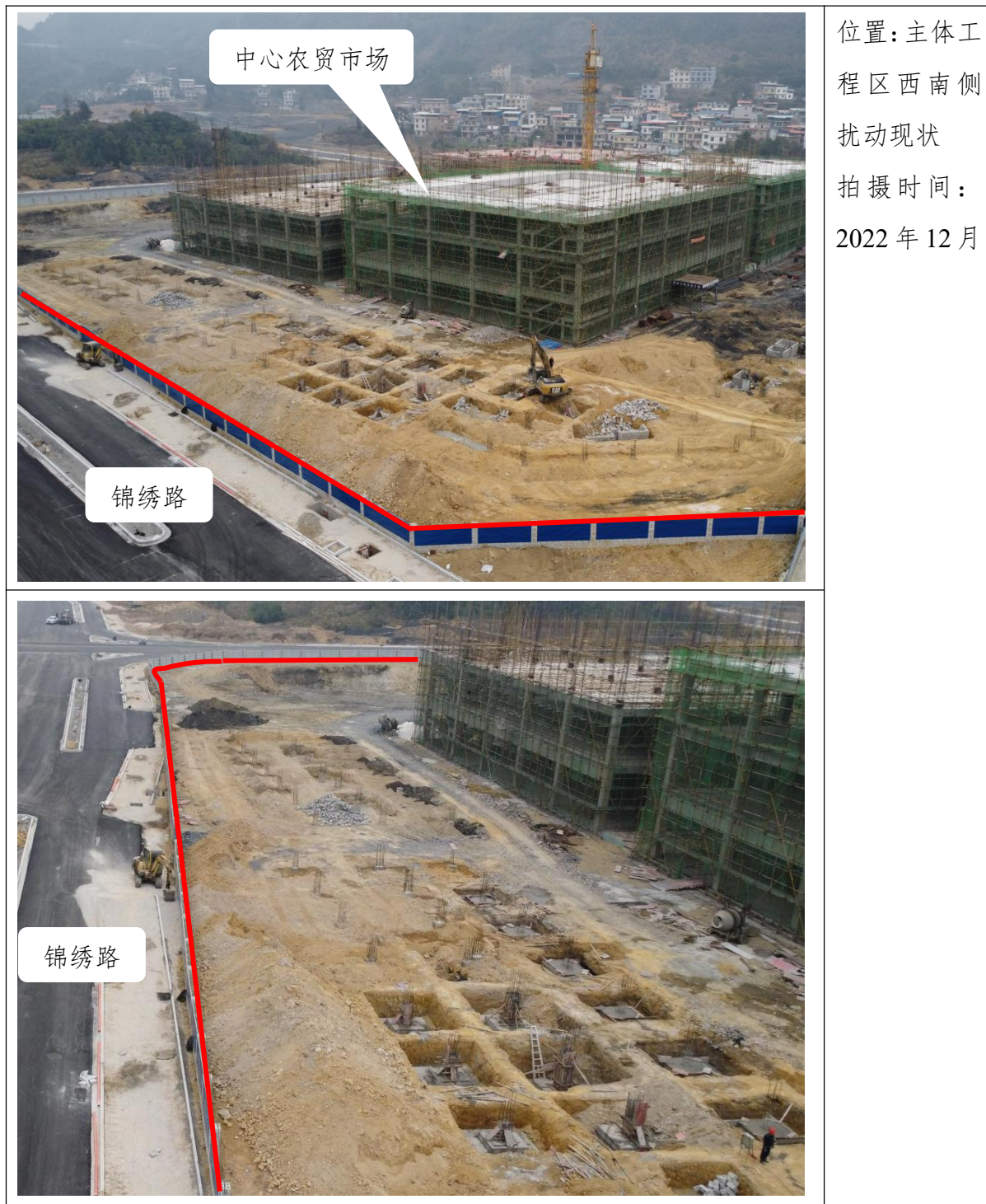
图 3.1-1：主体工程区场地照片
