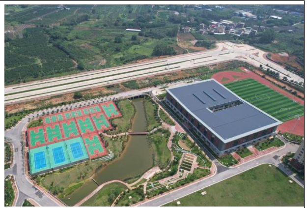
综合体育训练馆
