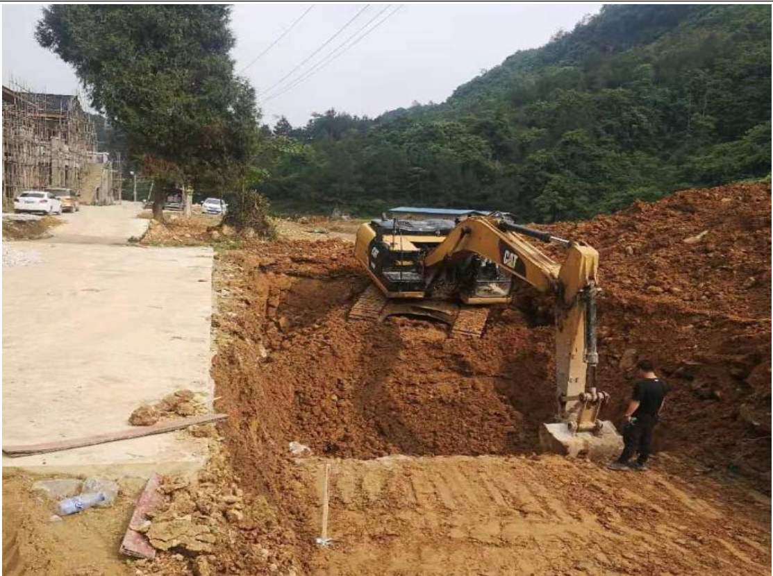
主体工程施工现状（六）
