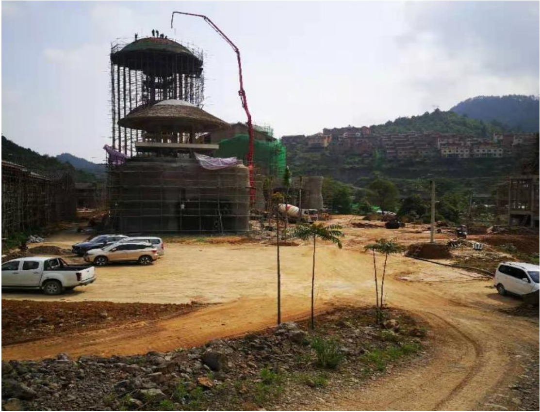
主体工程施工现状（五）
