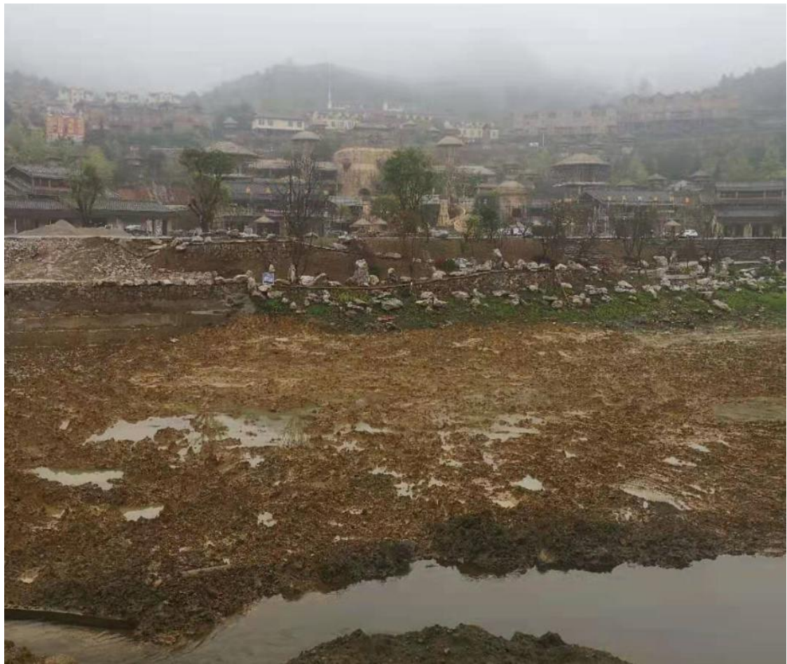
主体工程施工现状（二）
