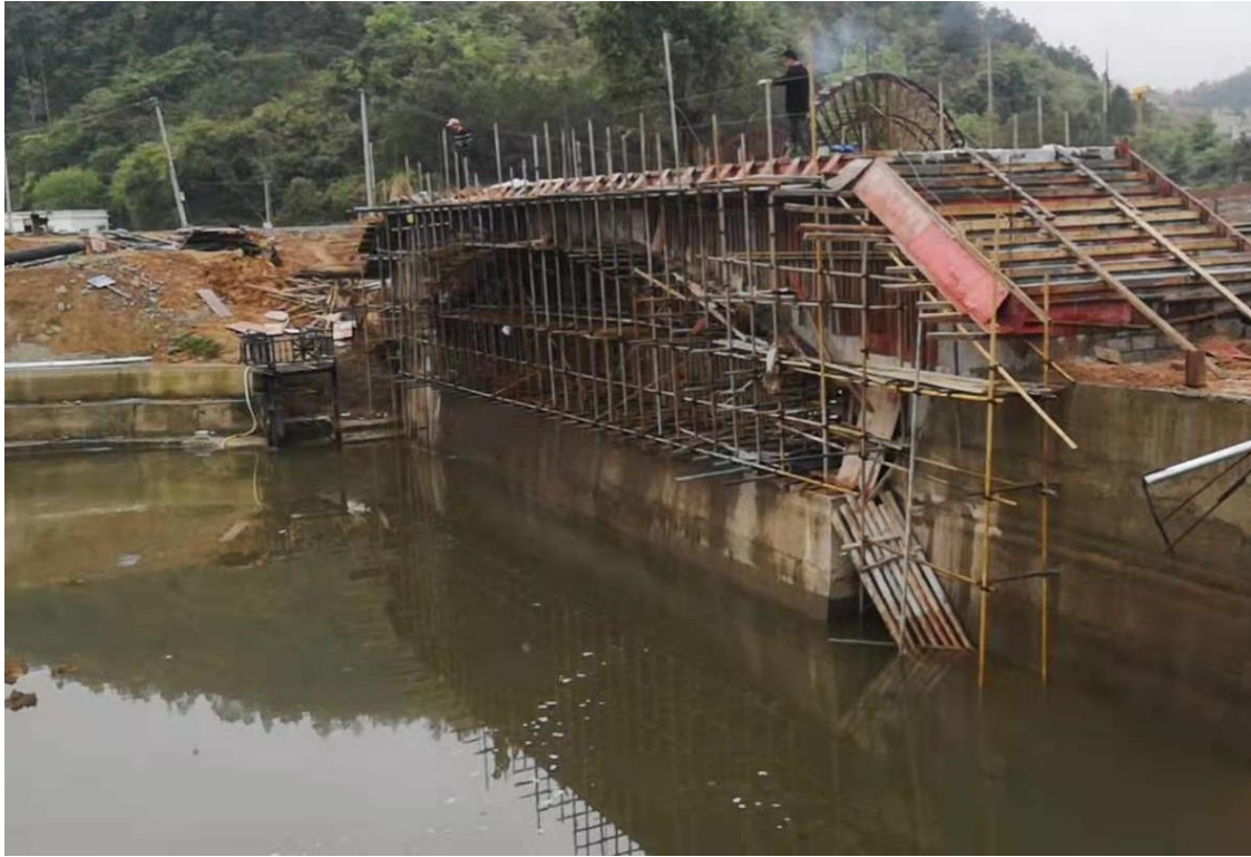
主体工程施工现状（一）
