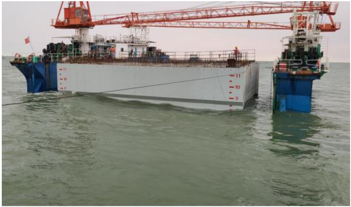
5#码头第 14 件沉箱安装
