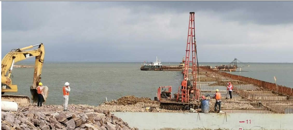
2#码头箱内回填贯入度检测
