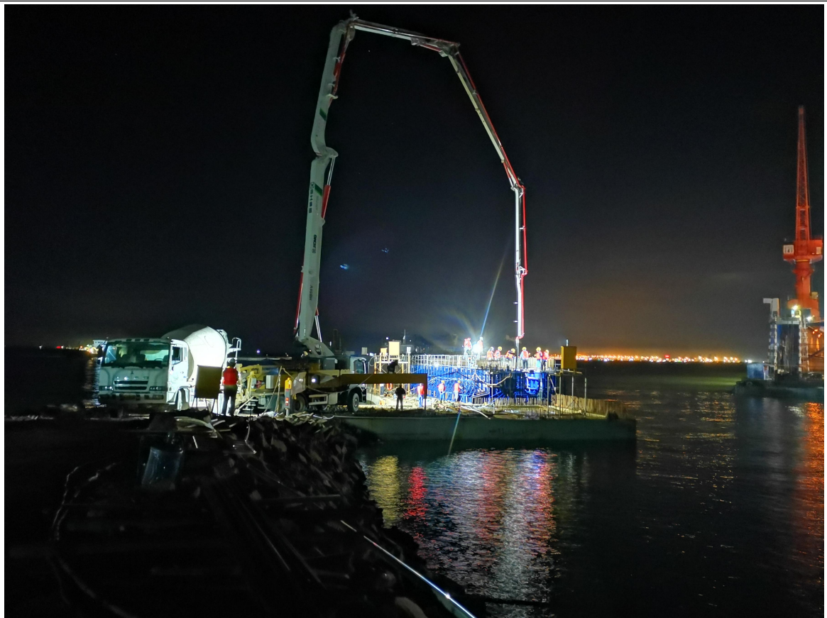
5#码头廊道（首段）浇筑
