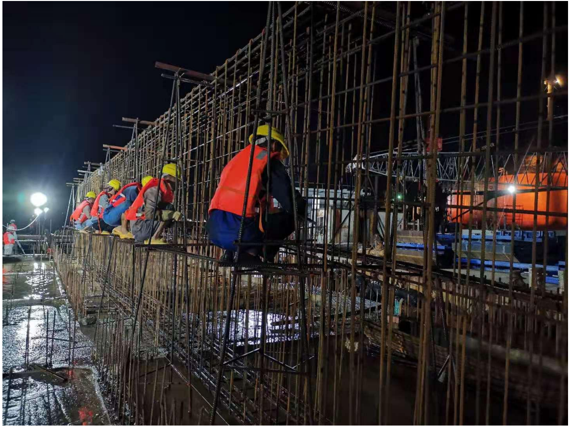
5#码头廊道钢筋绑扎
