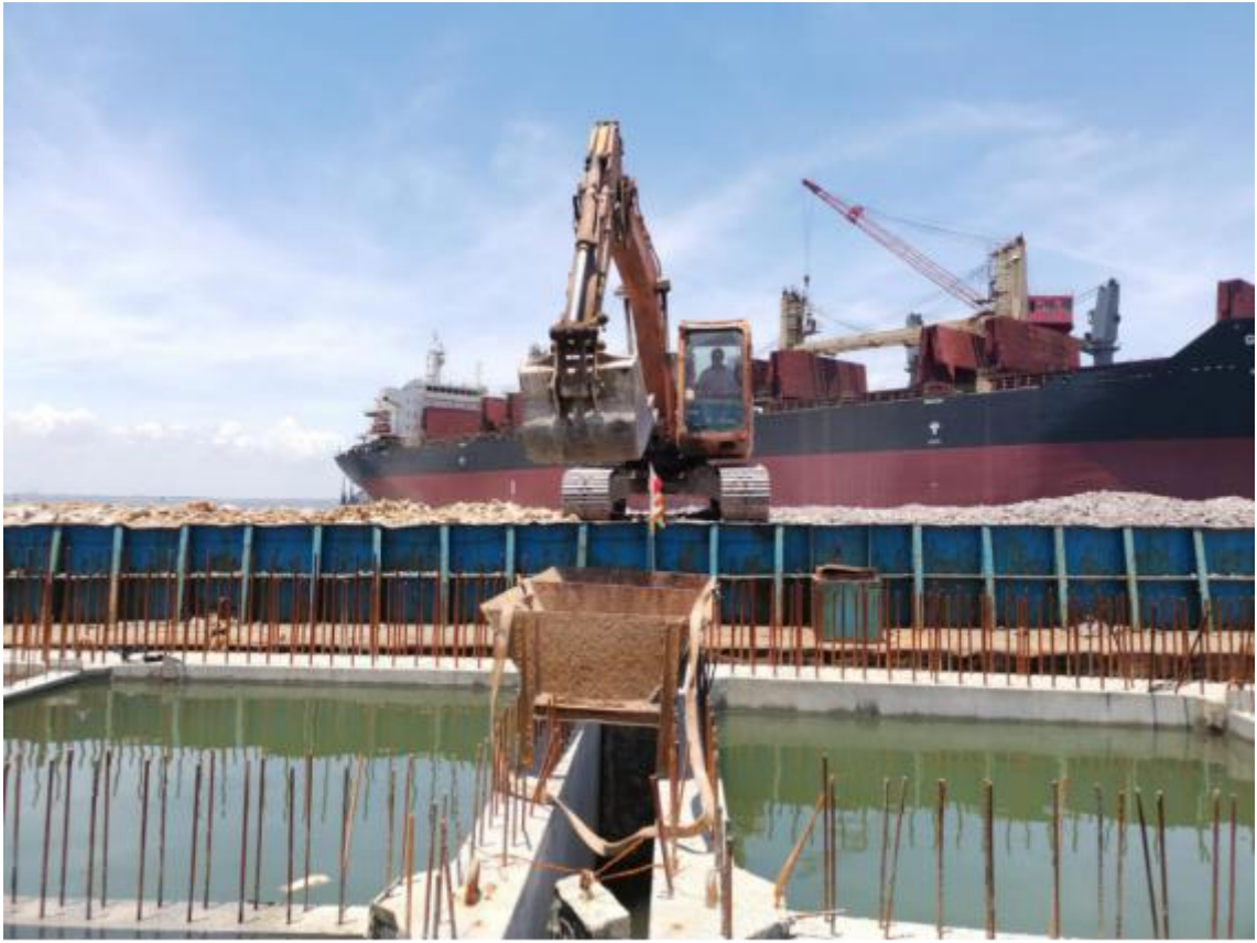
5#码头沉箱倒滤施工
