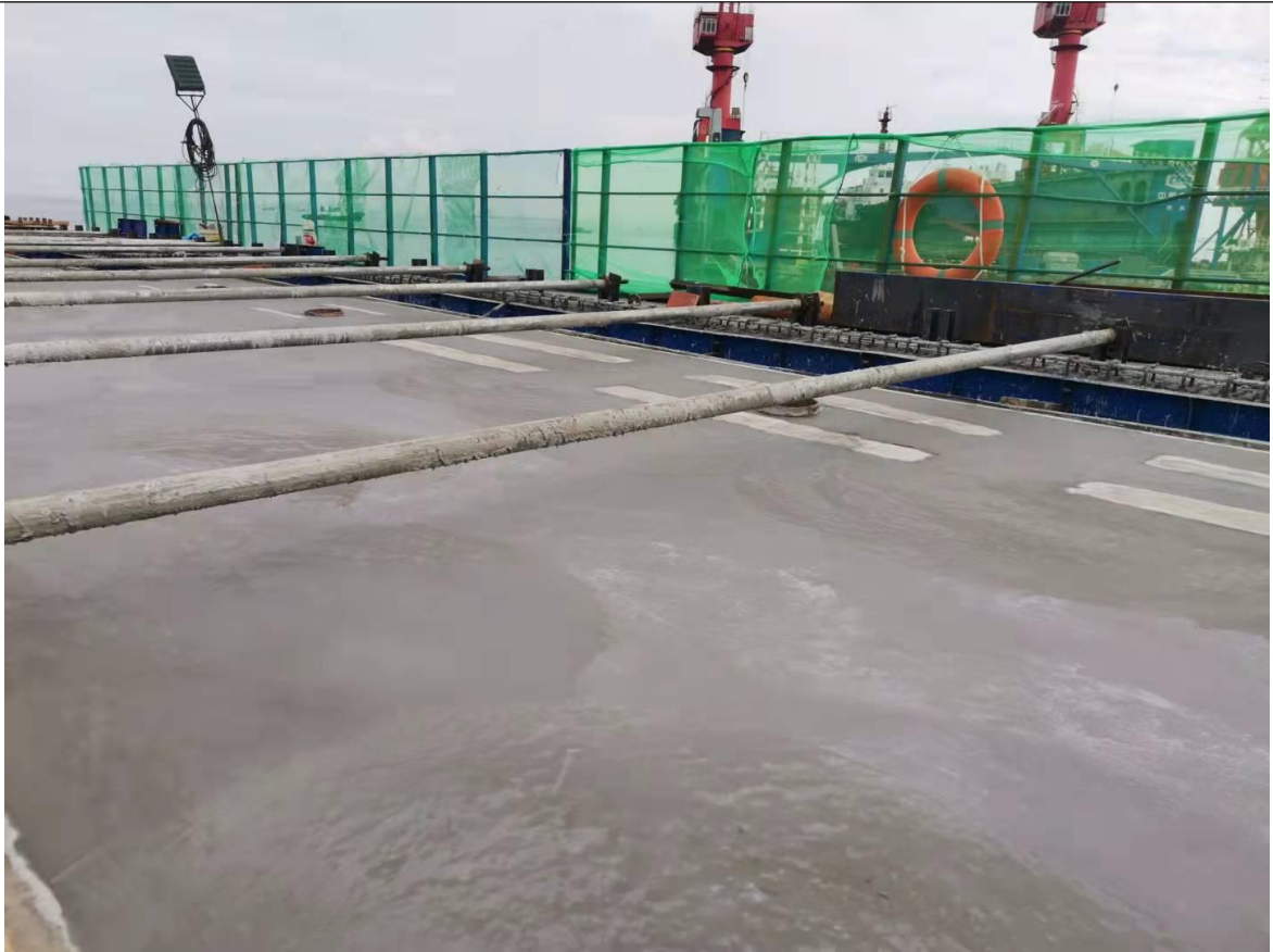
5#码头-2 廊道第二层（首段）浇筑
