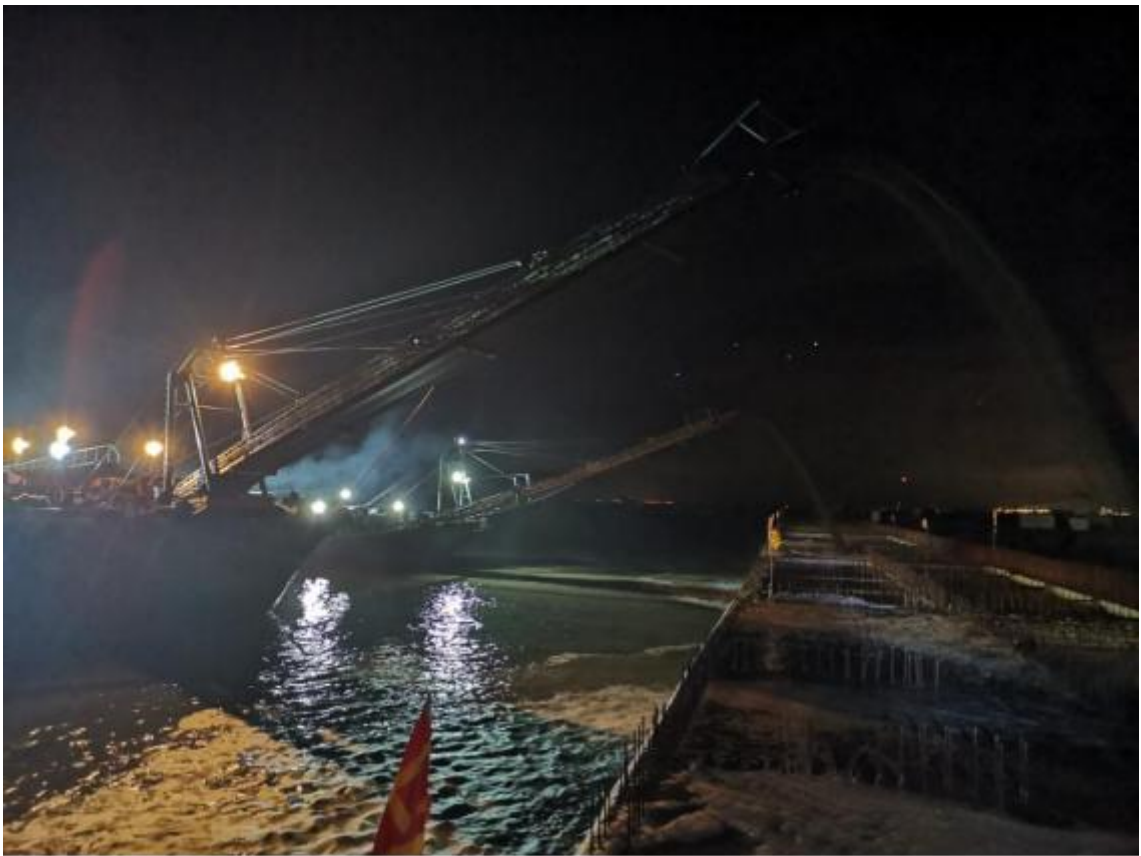
5#码头沉箱内回填砂
