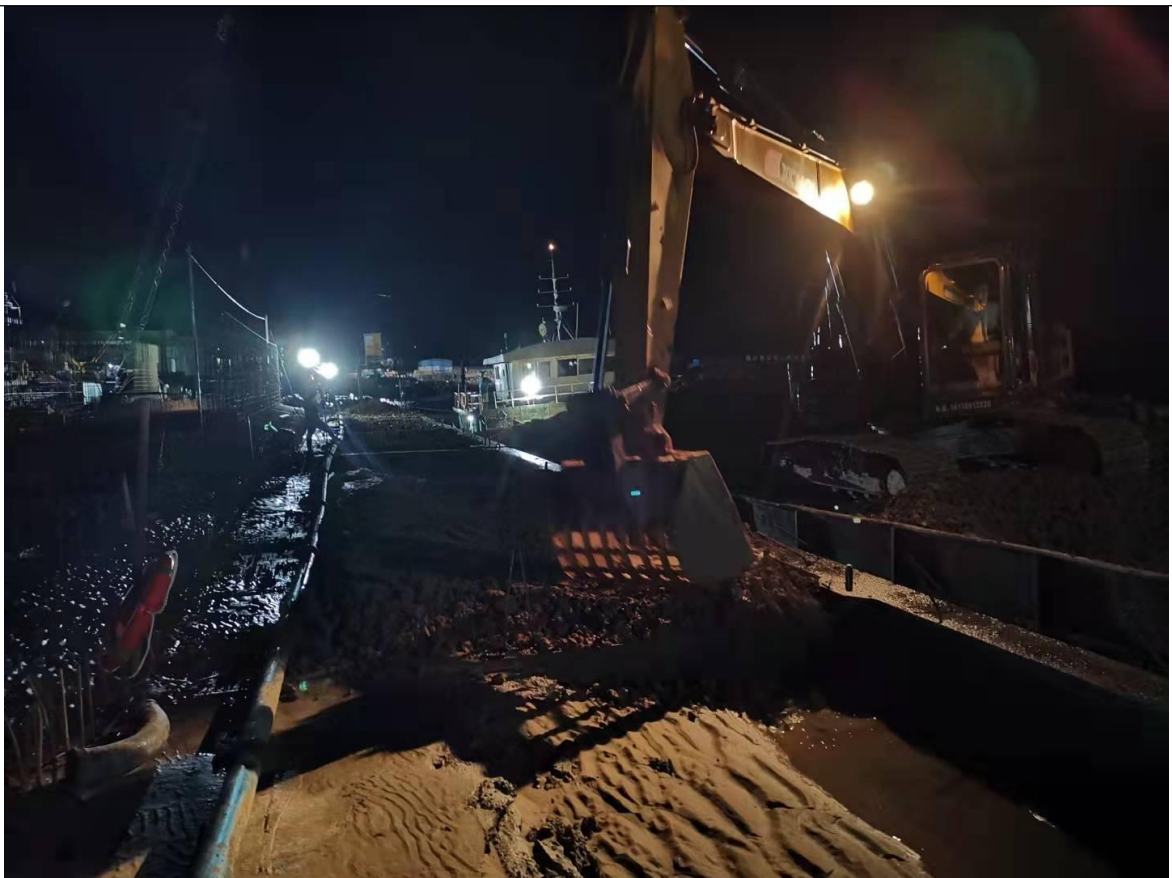
5#码头箱内回填施工
